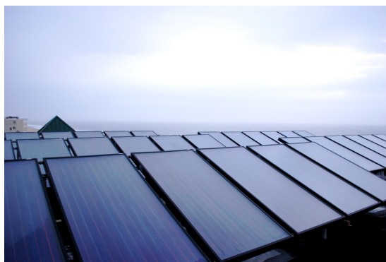
FIGURE 8.1 – Collecteur Flat-plate
