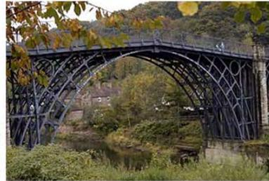
*(gauche) Coalbrookdale en 1801, village où furent installés les premiers haut-fourneaux au coke, et où furent coulées les pièces du « Iron bridge ». (droite) Premier pont métallique (fonte), « Iron Bridge », Angleterre, 1779.*
