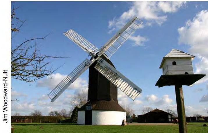
*Ailes à jalousie sur le moulin d'Outwood (UK). Le moulin fut construit en 1665, et ce type d'ailes fut installé plus tard.*
