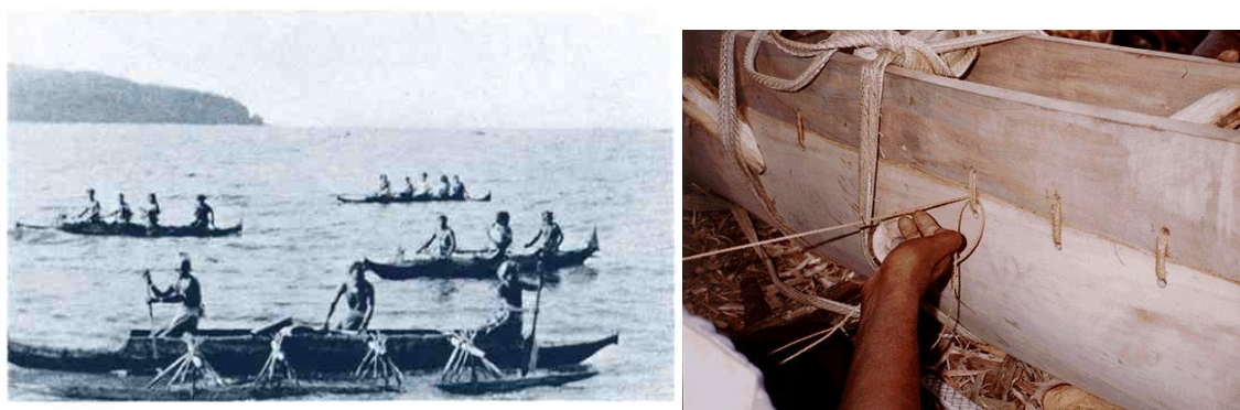
Figure 14 : (gauche) Photo de canoés Tikopiens prise en 1933 [Canoes of Oceania]. (droite) Artisan moderne cousant la virure sur la coque d'un canoé, avec la même méthode que celle utilisée par les Tikopiens [Kapingamarangi].
