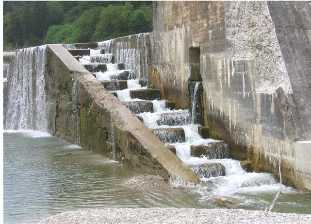
FIGURE 3.11 – Photographie d'une échelle à poisson pour remonter un barrage sur l'Isar en Allemagne. (Source : Wikipedia)
