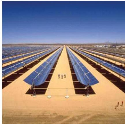
FIGURE 6.13 – Centrale solaire thermodynamique à capteurs cylindro-paraboliques. (Source : Vista Energy LP.)
