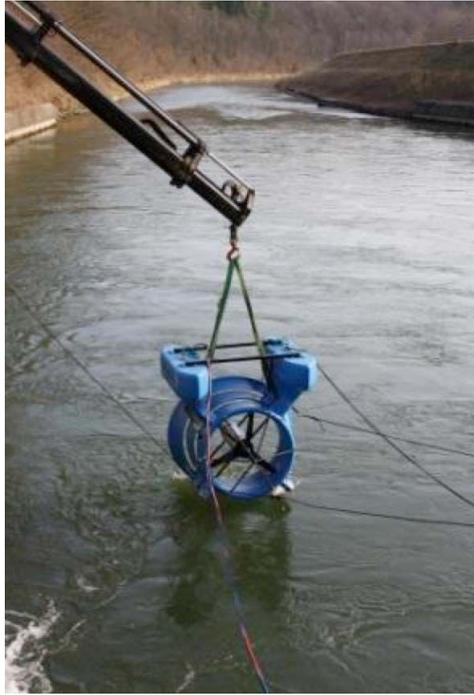
FIGURE 3.10 – Photographie de l'installation d'une turbolienne de 5 kW de l'entreprise Smart Hydro Power sur la rivière Isar. Source : Smart Hydro Power, 2011.
