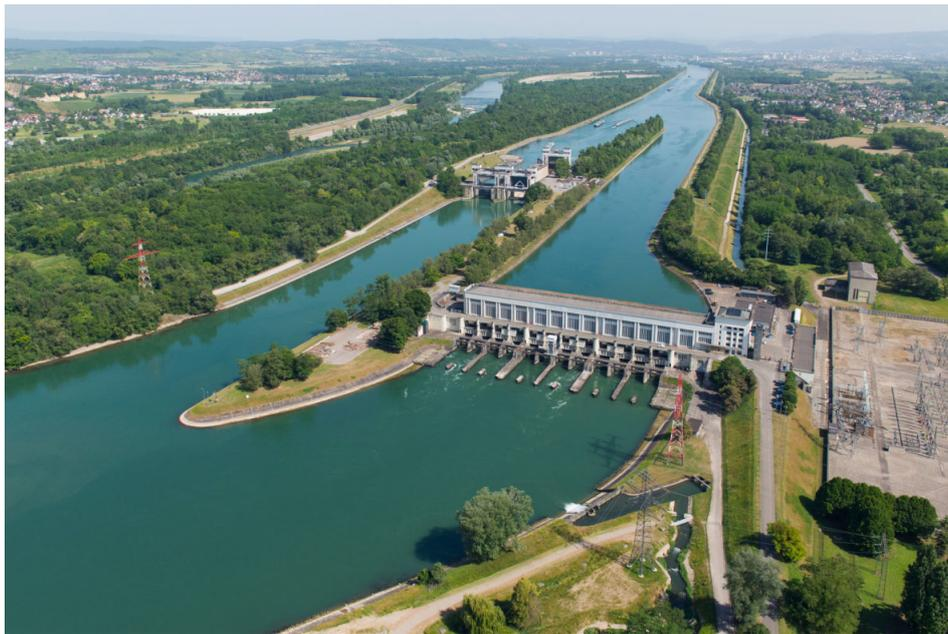
FIGURE 3.4 – Photographie de la centrale au fil de l'eau de Kembs en Alsace. (Source : aufildu-rhin.com)
