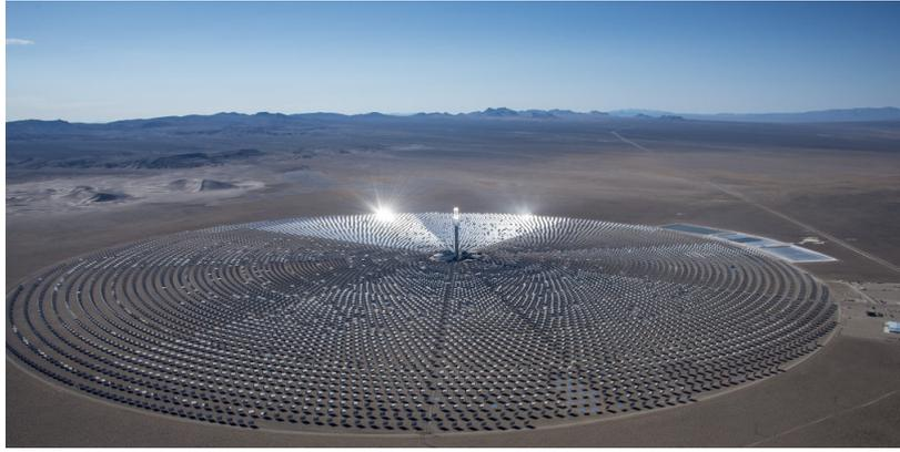
FIGURE 6.14 – La centrale de Crescent Dunes aux USA. Elle a une capacité de production de 110 MW et une capacité de stockage de 1 GWh. La centrale n'atteignant que 40 % de la production prévue, est fermée depuis avril 2019 et l'entreprise SolarReserve se trouve en faillite [170].
