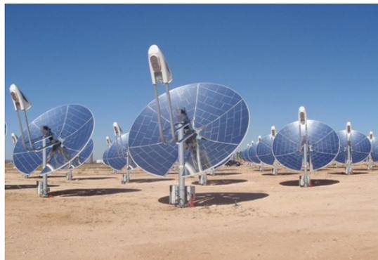
FIGURE 6.15 – Parabole de Stirling de l'entreprise espagnole Revolvía. (Source : Revolvía.)
